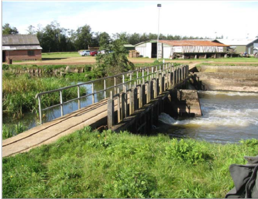
Figur 2.2.4: Stemmeværket ved Gelsbro Dambrug. Til højre ses betonvæggen til den eksisterende faunapassage/fisketrappe (kammertrappe med dykket indløb).
