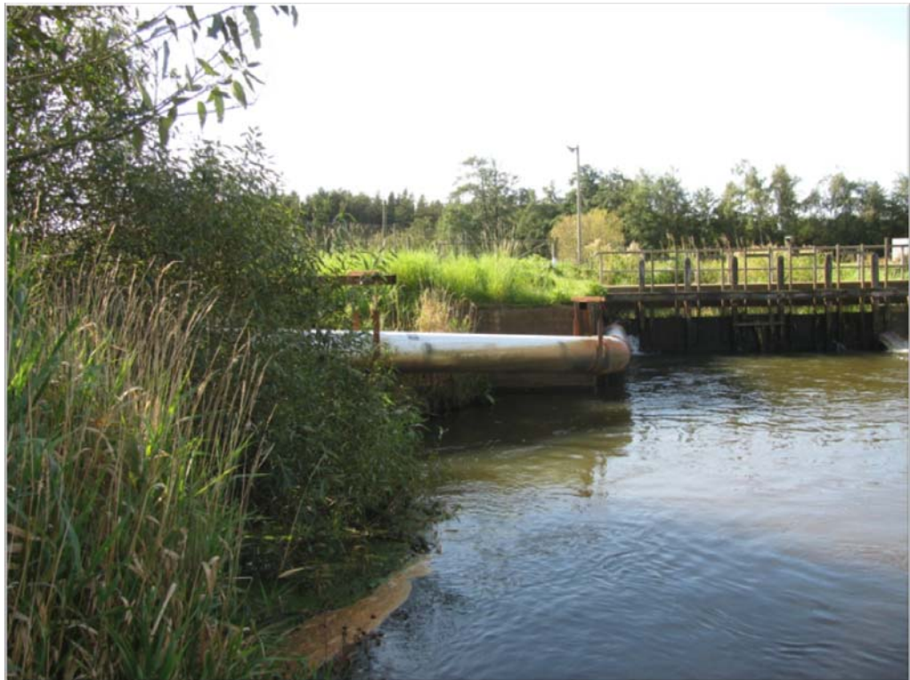
Figur 2.2.2: Rør som leder vandet fra fældningsbassinet (beliggende til venstre uden for foto) til udledning opstrøms stemmeværket.
