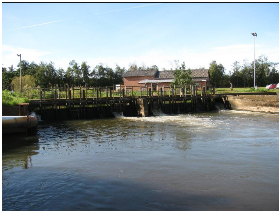
Figur 3.3.1: Stemmeværket og fisketrappen set nedstrøms fra og fra den østlige vandløbsbred. Fisketrappens sidemur mod vandløbet ses som en skrånende kant i billedets højre side.
