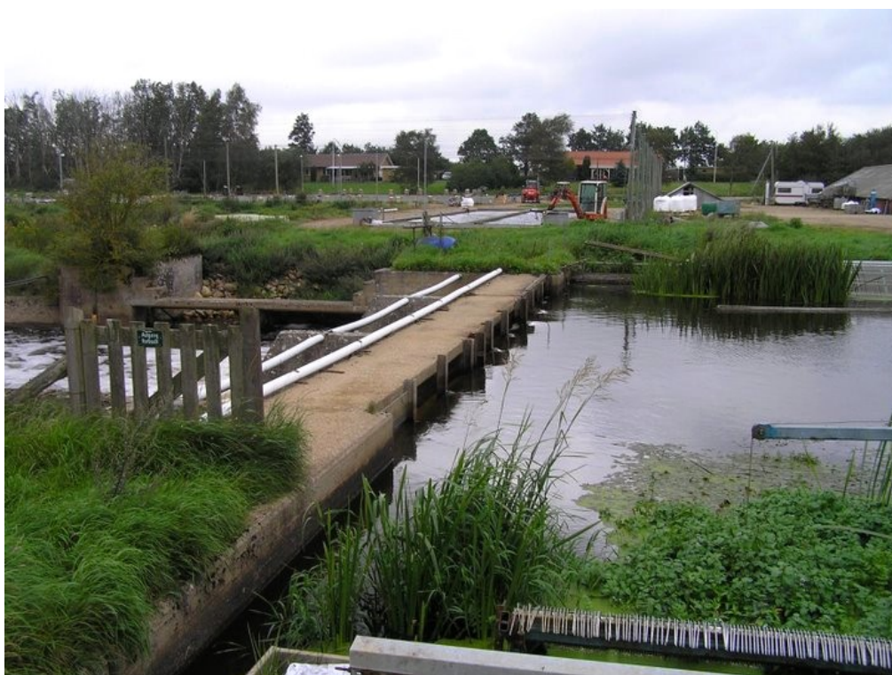
Figur 2-2 Fotoet viser stemmeværket ved Fole Dambrug, og den tydelige vandspejlsforskel op- og nedstrøms opstemningen. I baggrunden ses selve dambruget.
