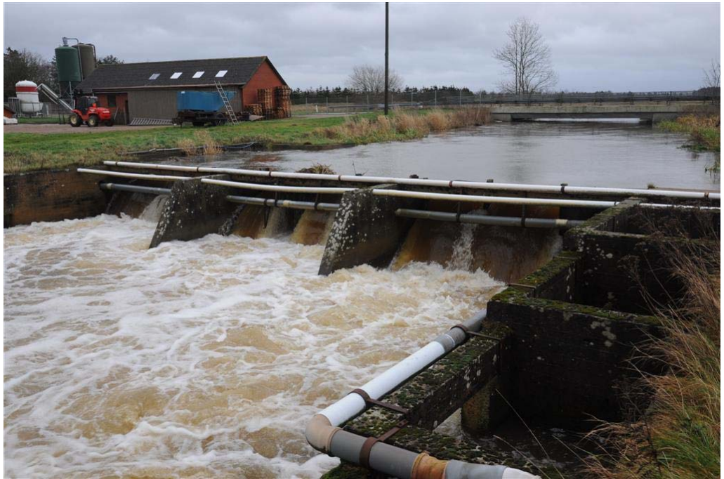
Figur 1-1 Billede fra opstemningen ved Fole Dambrug en novemberdag med meget høj vandføring.
