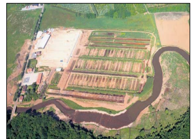
Sig Fiskeri med de nye betondamme øverst til venstre. Det nye stenstryg, der har erstattet den tidligere opstemning, ses i forgrunden - Foto: Henrik Reintoft, Jyske Vestkysten.
