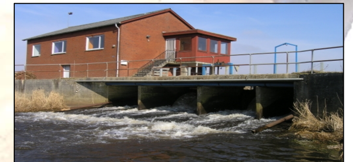
Den tidligere opstemning ved dambruget kunne ikke passeres af snæbler. Nu er både opstemning og hus fjernet.
