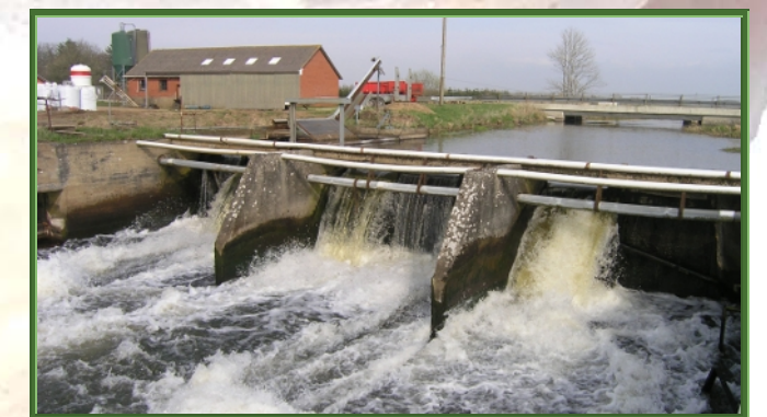
Opstemningen ved Fole Dambrug har hindret fiskenes videre passage op i Gram Å. Den fjernes i løbet af 2012.
