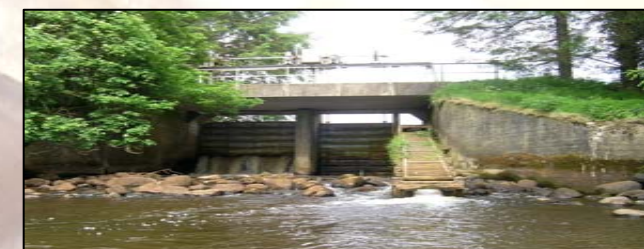
Ansager Stemmeværk fordelte gennem 55 år vandet med 90% til Ansager Kanal og kun 10% til Varde Å.
