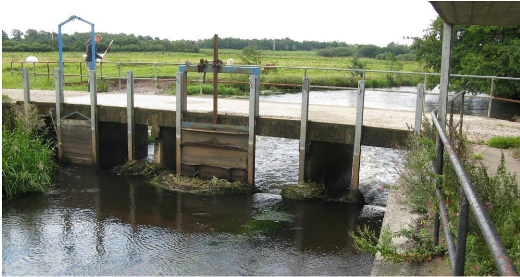
Figur 2.9 Stemmeværket på østsiden af broen. Ved besigtigelse d. 18. august var 2 af sluseportene nede.
