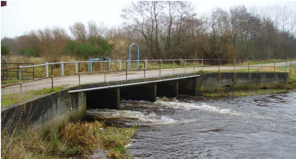
Figur 2.8 Broen over Fiskerivej ved Bramming Fiskeri. Broen er udført i insitustøbt beton som et "kassedragertværsnit" – det vil sige en betonbundplade, 5 bærende tværvægge (2 endevederlag og 3 mellemunderstøtninger) og et betondæk
