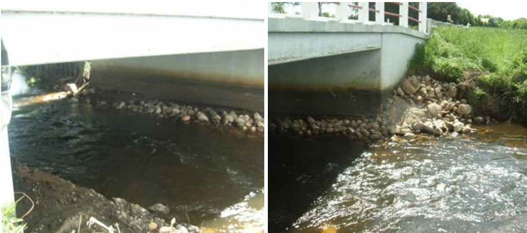
Figur 2.10 Stensikringen ved den underminerede, sydlige bro pille. Ved den nordlige bro pille optræder et ca. 1 meter bredt plateau med asfaltbelægning. De to afsatser indsnævrer vandsluget til ca. 6 meter i situationer med lav vandstand. Bemærk den tydelige markering på bro pillen af hvor højt vandstanden tidligere har været
